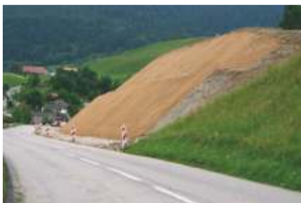
Vorher: Erosionsschutz mit EcoTex®-Kokosgewebe
