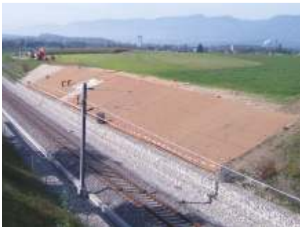
Pose d'un filet en fibres de coco.
