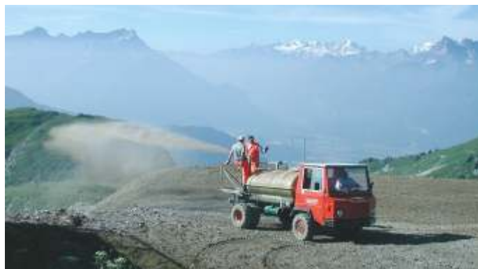
Semis hydraulique sur le domaine skiable de Leysin.
