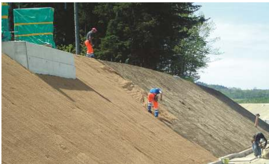
Filets en fibres de coco EcoTex ® pour la stabilisation du sol.
