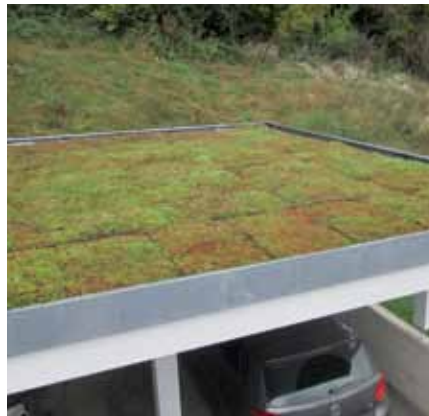
Carport in Corsier-sur-Vevey
