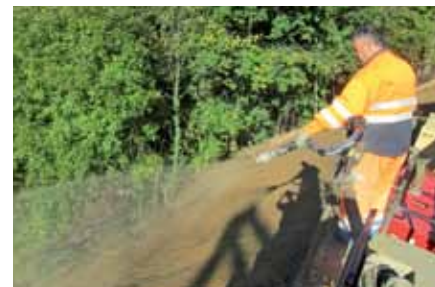
Végétalisation par semis hydraulique
