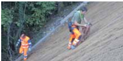
Pose du géotextile EcoTex
