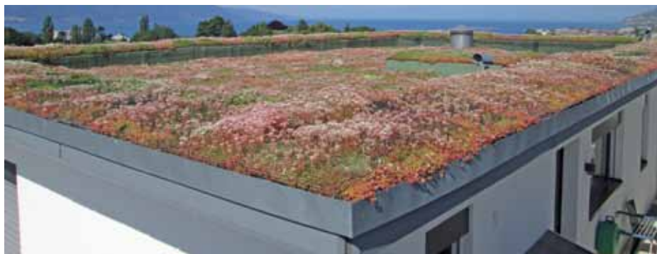
Toiture XeroFlor® à La Tour-de-Peilz
