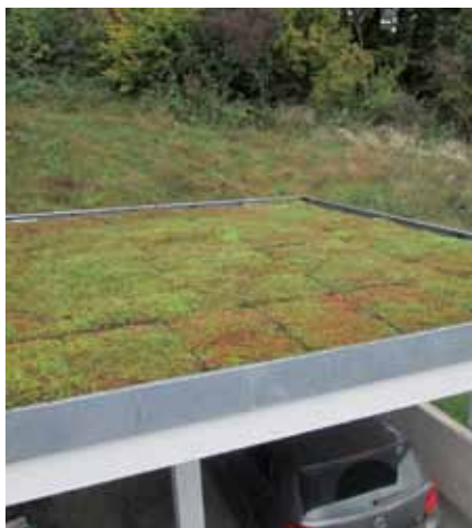
Abri pour voitures à Corsier-sur-Vevey
