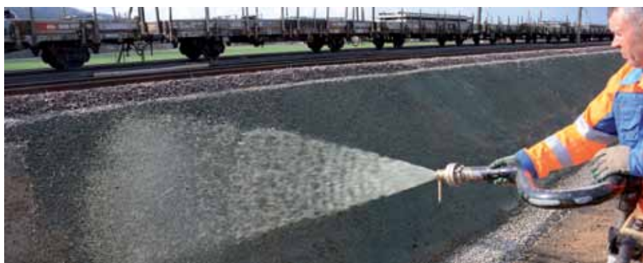
Le produit liquide anti-érosion est projeté en plusieurs couches.
