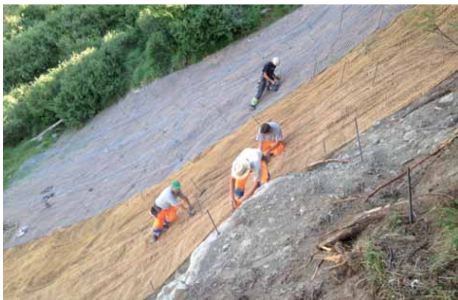
La pose des filets de coco et des géotextiles
