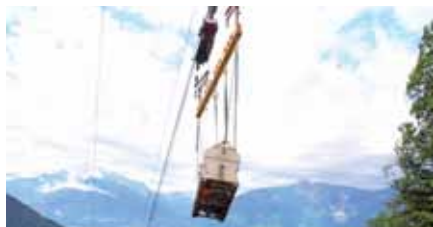
Transport du seeder au-dessus de la pente escarpée à l'aide du blondin
