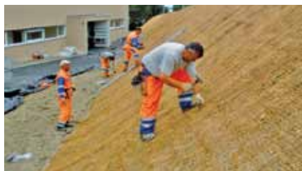
Pose de géotextile EcoTex en fibres de coco
