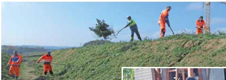
L'équipe exécute les travaux d'entretien.
