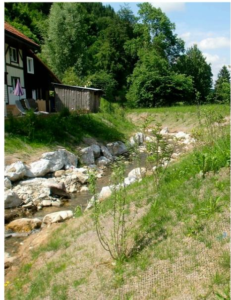
**Einsatzmöglichkeiten** Überall wo die Gefahr von Erosion besteht
