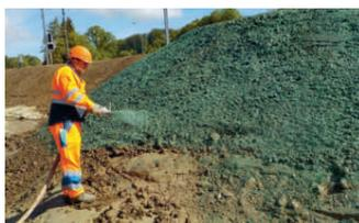
Letzter Arbeitsschritt mit HydroSaat Protect als Erosionsschutz.
