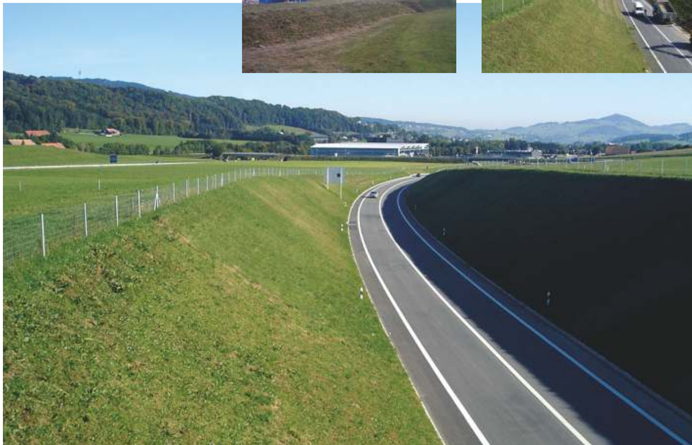
Erfolgreich angesäte Böschungen.
