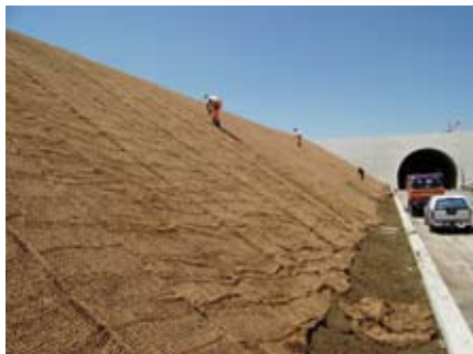
Verlegen der Kokosmatten...
