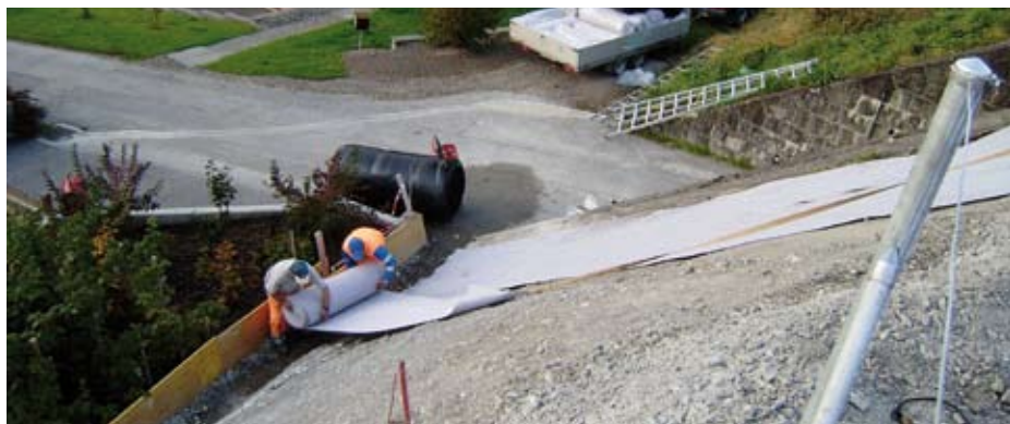
Verlegen der Speichermatten
