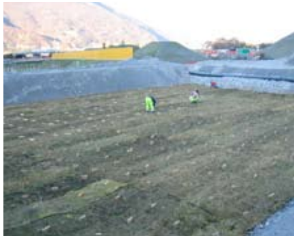
Eine ÖkoSABA im Bau
