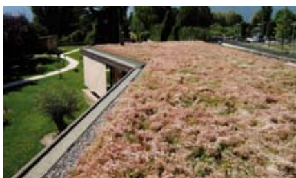
Eine harmonische Dachbegrünung
