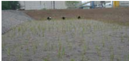
Im Hintergrund sind die Wassereinlaufrohre sichtbar
