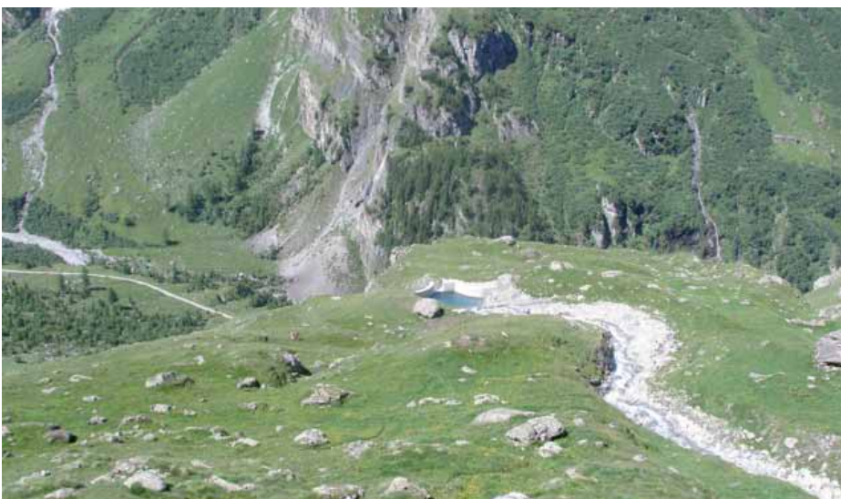
Ein Wasserretentionsbecken inmitten der begrünten Fläche
