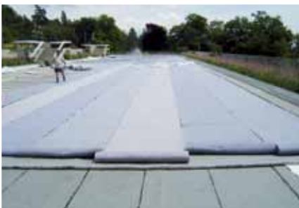
Der Aufbau der Dachbegrünung wurde schon vorbereitet
