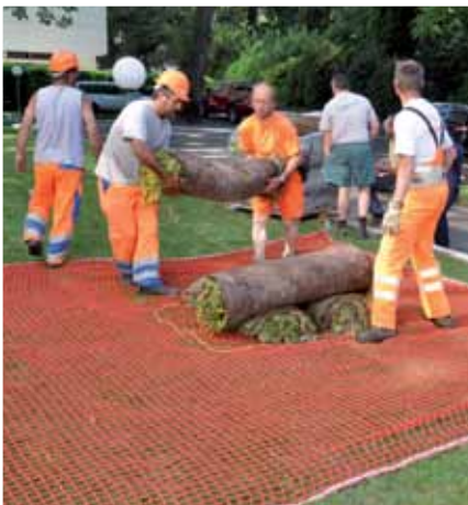
Die Sedummatten werden in die Transportnetze palettiert
