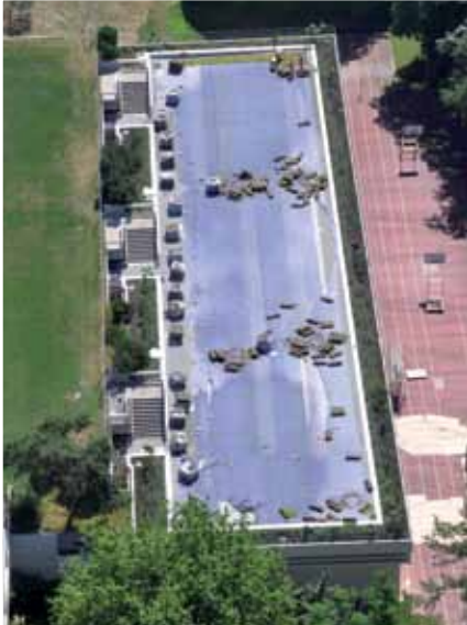
Luftansicht nach dem gelungenen Abladen der Rollen
