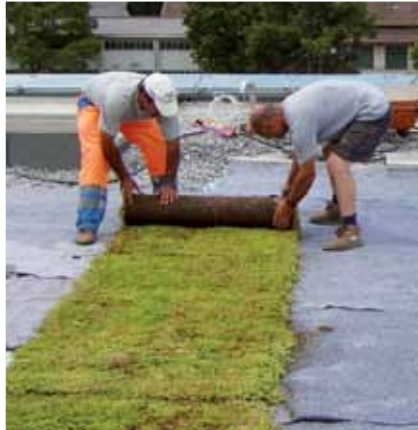
Die Xeroflor® Vegetationsmatten werden verlegt...
