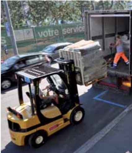
Abladen der Vegetationsmatten vom Kühllastwagen
