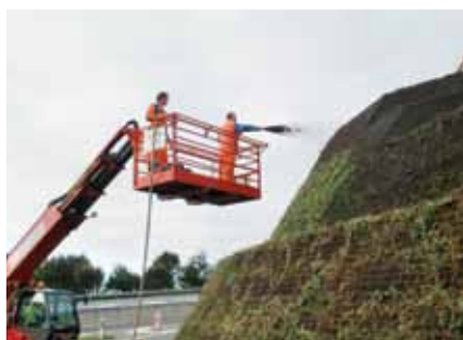
Auftrag des Substrats
