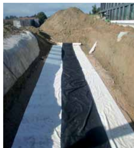
Untergrundvorbereitung mit Kiesbett, Schutzvlies und Dichtungsbahn
