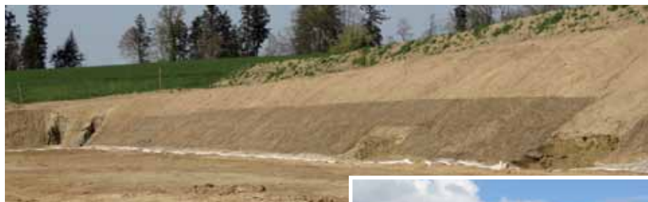
Sandsteinböschung mit Kunststoffnetz zur Stabilisierung
