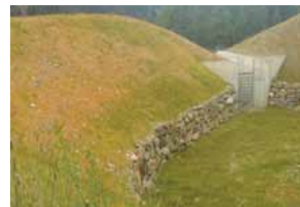
Der Abfluss des riesigen Rückhaltebeckens
