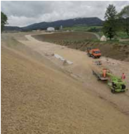
Auftragen des Langstrohs
