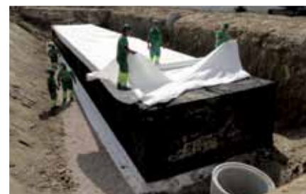
Fertigstellung mit Schutzvlies und Dichtungsbahn aus synthetischem Kautschuk
