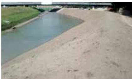
Böschungskanal vor der Ansaat
