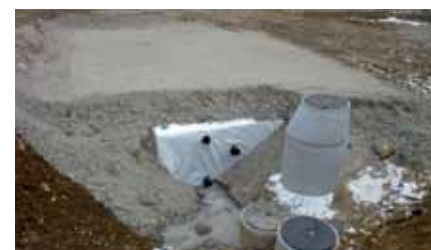
Einerden der Anlage mit Kies und Humus
