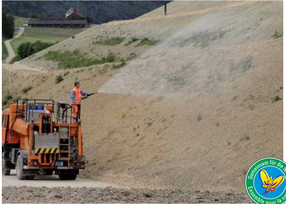
Aufspritzen des Klebers auf Langstroh
