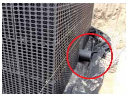
Vue détaillée avec la sortie d'eau
