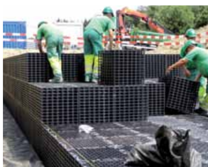
Montage expéditif des blocs ENREGIS®
