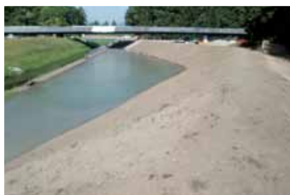
Le talus du canal avant l'ensemencement...
