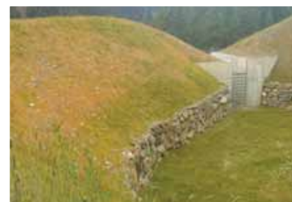
Zone d'écoulement du bassin de rétention
