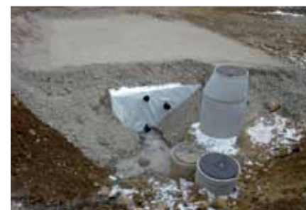
Remblayage de l'installation avec des matériaux fins
