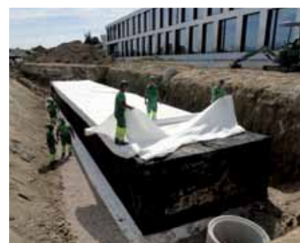
Emballage final du bassin de rétention
