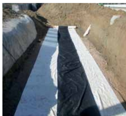
Un lit de gravier, une natte de séparation non tissée et un revêtement d'étanchéité
