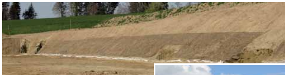
Talus en molasse protégé par un filet en matière synthétique
