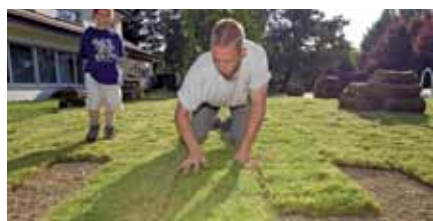
Die vorkultivierten Bahnen werden ausgerollt
