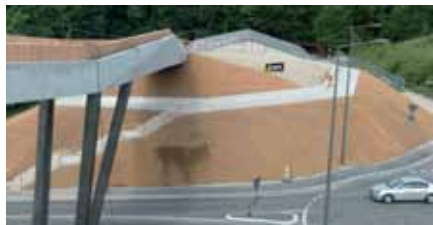
Kokosnetze fachmännisch ausgelegt
