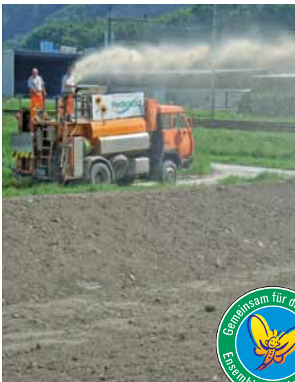
Ansaat der Wasser-Rückhaltebecken
