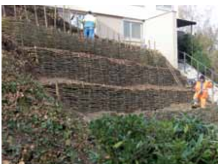
Hangstabilisierung mit Weiden
