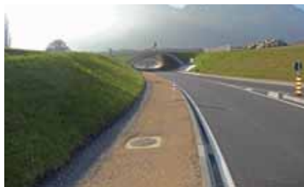
Erfolgreiche Begrünung der Böschungen
