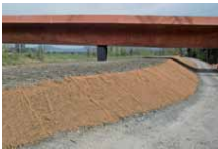
Kokosnetze schützen vor Erosion
