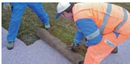
Die Sedummatten werden ausgerollt
