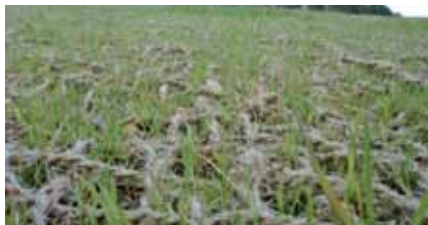
Les filets en fibres de coco garantissent la végétation.
