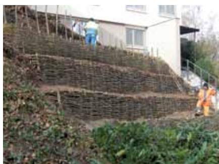
Stabilisation de terrain
