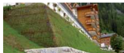
Mur en terre armée Bostamur végétalisé
