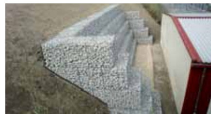
Stabilisation avec des gabions Rubo
