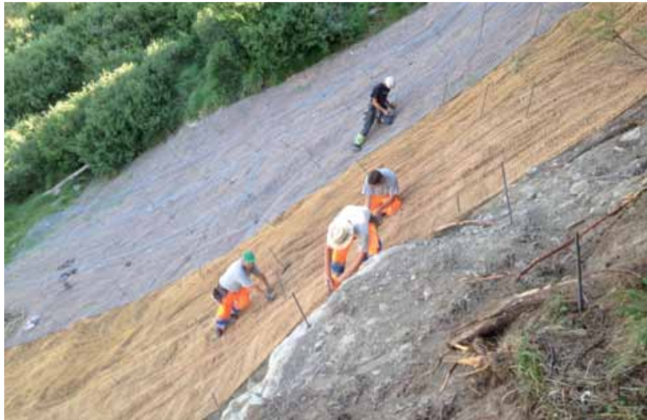
Beim Verlegen der Kokosnetze und des Geokunststoffgewebes
