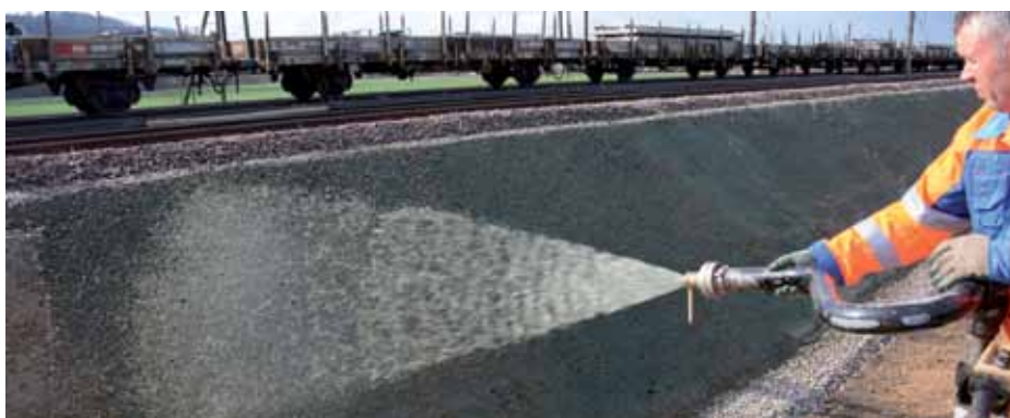
Der flüssige Erosionsschutz wird mehrschichtig aufgespritzt.
