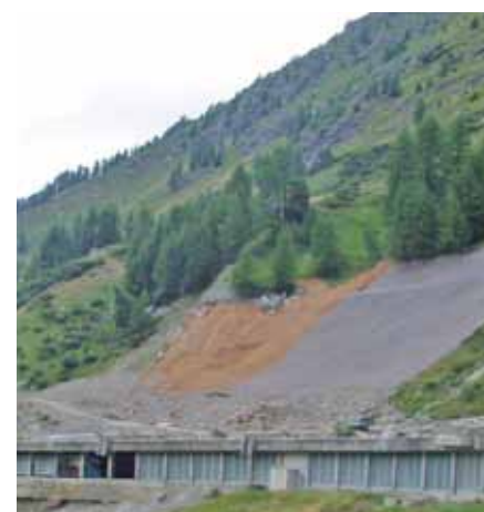
Das steile Gelände fordert die Mitarbeiter.
