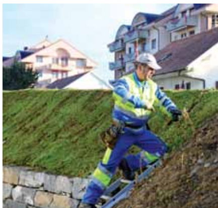
Fachgerechtes Verlegen der Sedummatten
