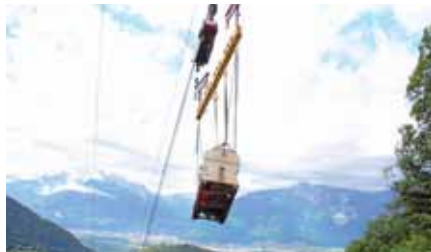
Transport des Seeders mit Kabelkran in den Steilhang
