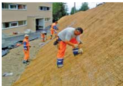
Gemeinsam werden Kokosnetze verlegt.
