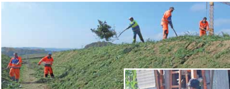
Das Team erledigt Unterhaltsarbeiten.
