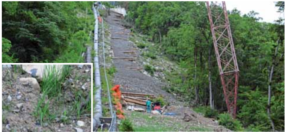
Gesamtansicht der Baustelle mit wachsendem Grün im unteren Teil
