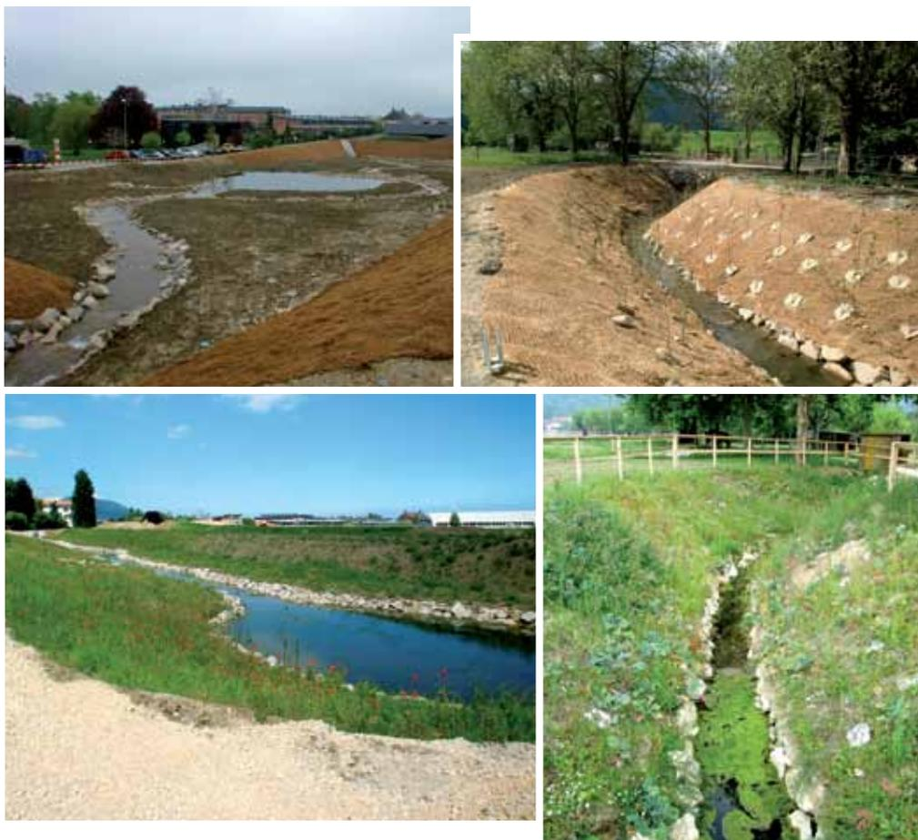
Semis d'un bassin de rétention à Boudry et pose de rondelles de feutre pour la protection des végétaux
