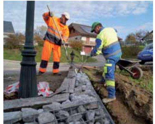
Du fait que les gabions sont remplis de pierres de taille, de gravier concassé ou de boulets, l'eau peut s'écouler librement. En y appliquant préalablement un tissu filtrant perméable, on empêche le remblai de s'infiltrer dans la construction **FlexiGab**.
