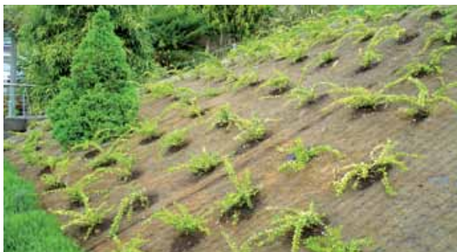
Verlegte Mulchmatten aus Kokosfasern
