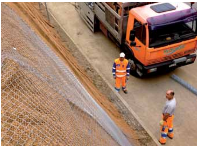
Romont: Zusätzliche Stabilität durch Drahtgitter
