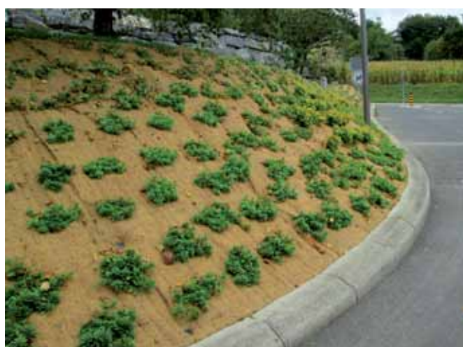
Mulchmatte G7 schützt die Fläche gegen Unkraut
