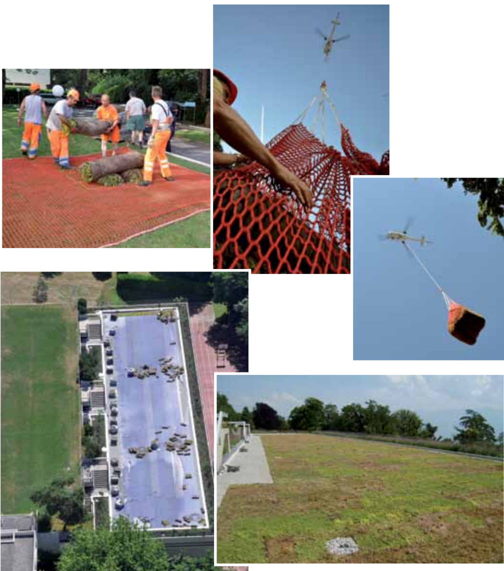
Eine nicht alltägliche Dachbegrünung aus der Luft in Lausanne - Elysée
