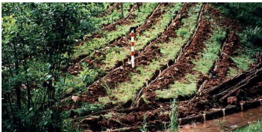
Weidenfaschinen zur Hangentwässerung
