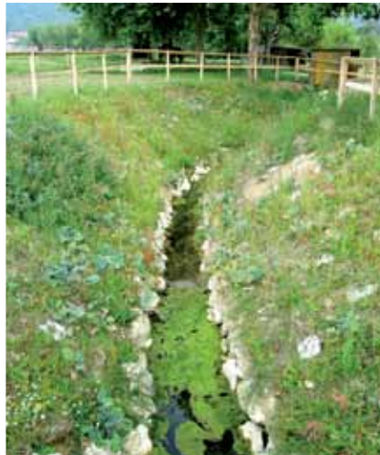
Ansaat eines Wasserretentionsbeckens in Boudry mit Mulchmatten als Pflanzenschutz
