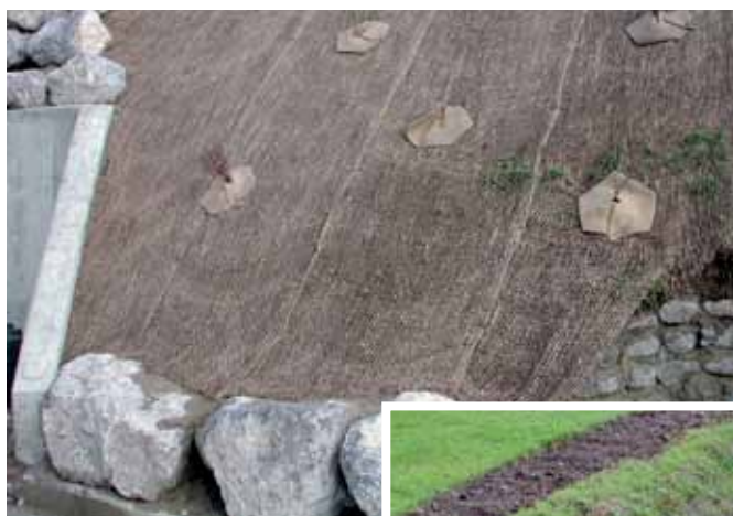
Verlegtes EcoTex - Jutenetz
