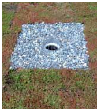
Perfektes Verlegen um die Dach-abläufe
