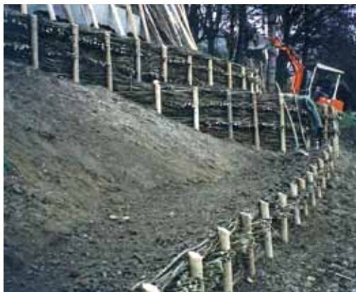
Kombinierte Bauweise mit Weidenfaschinen
