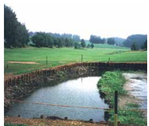
Vollständige Einfassung mit Weidenfaschinen
