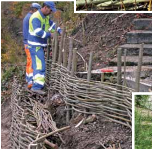
Hangsicherung in Bourguillon
