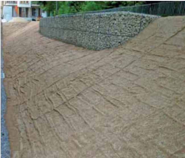
Erosionsschutz in Kombination mit FlexiGab
