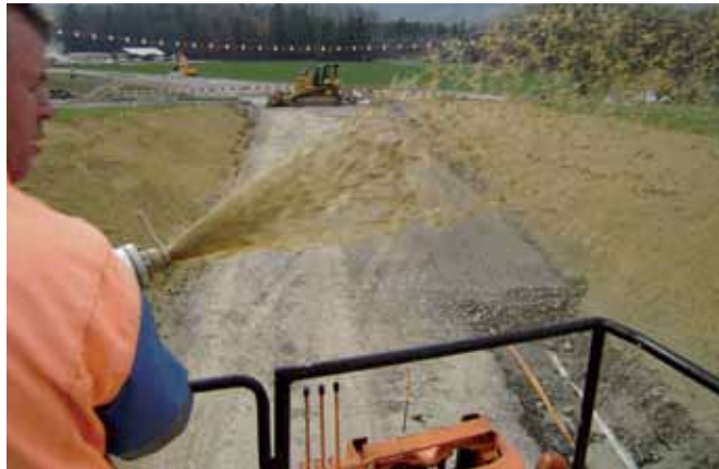
Anspritzen von Hydrosaat Protect
