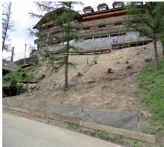
Hydrosaat Protect in Oberhünigen, vorher...
