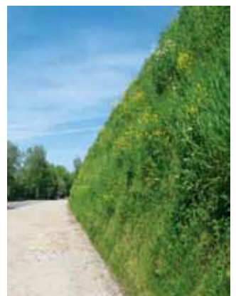
Steilböschung mit bewehrter Erde
