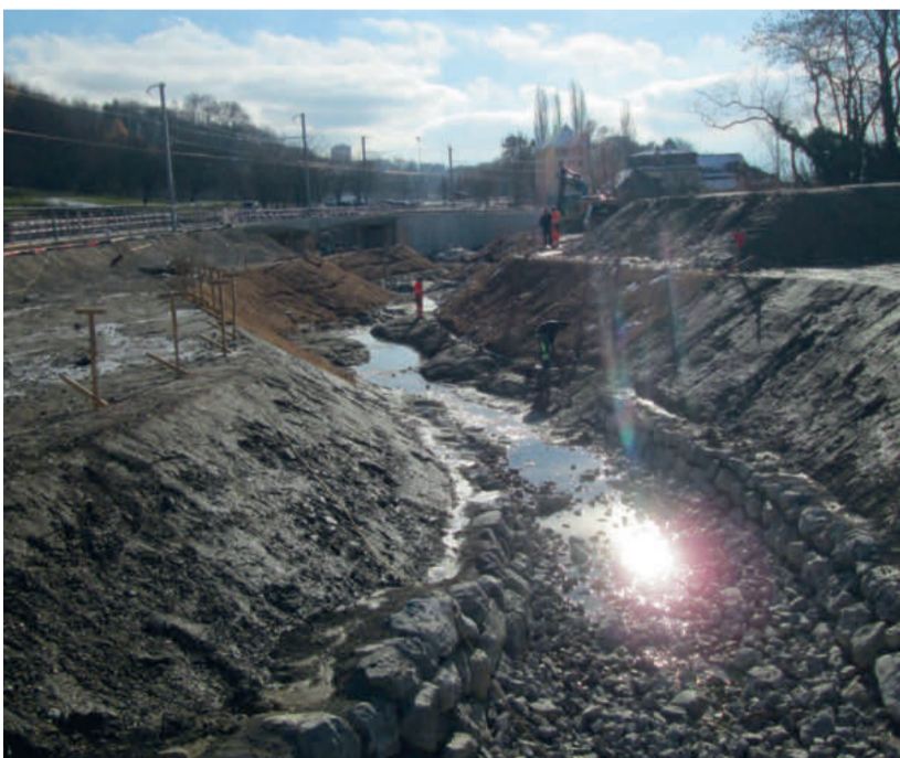
Les talus du ruisseau étaient constitués pour la plus grande partie de molasse et d'un fond sableux réfractaire au reverdissement.
