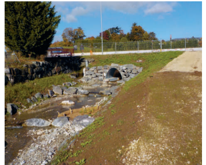
Les berges et le chemin d'accès ont été fauchés et ensemencés.
