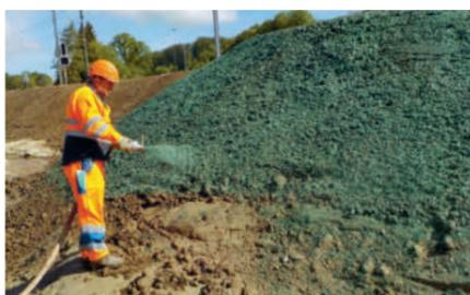
Letzter Arbeitsschritt mit Hydrosaat Protect als Erosionsschutz.
