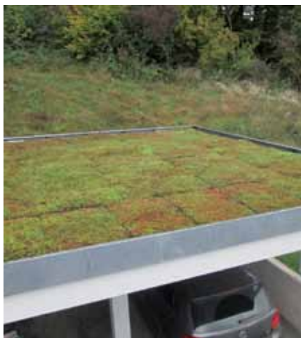
Abri pour voitures à Corsier-sur-Vevey
