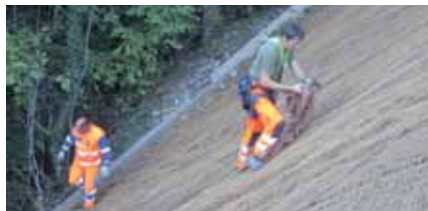
Pose du géotextile EcoTex
