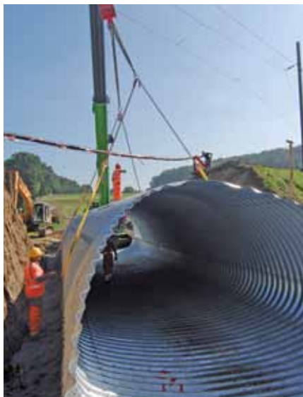
Pose d'un passage sous voie en acier ondulé à Belfaux
