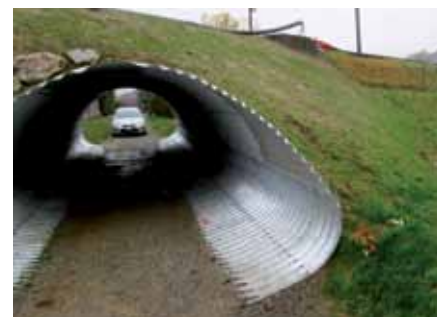
Pose d'un passage sous voie en acier ondulé à Belfaux
