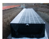
Bassins de rétention et d'infiltration
