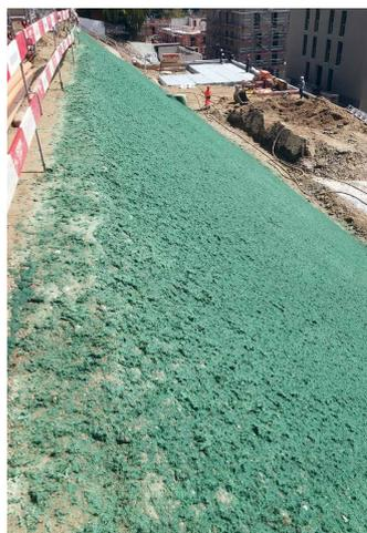
Les talus soumis aux risques d'érosion ont été recouverts avec la protection liquide *Hydrosaat Protect*.
