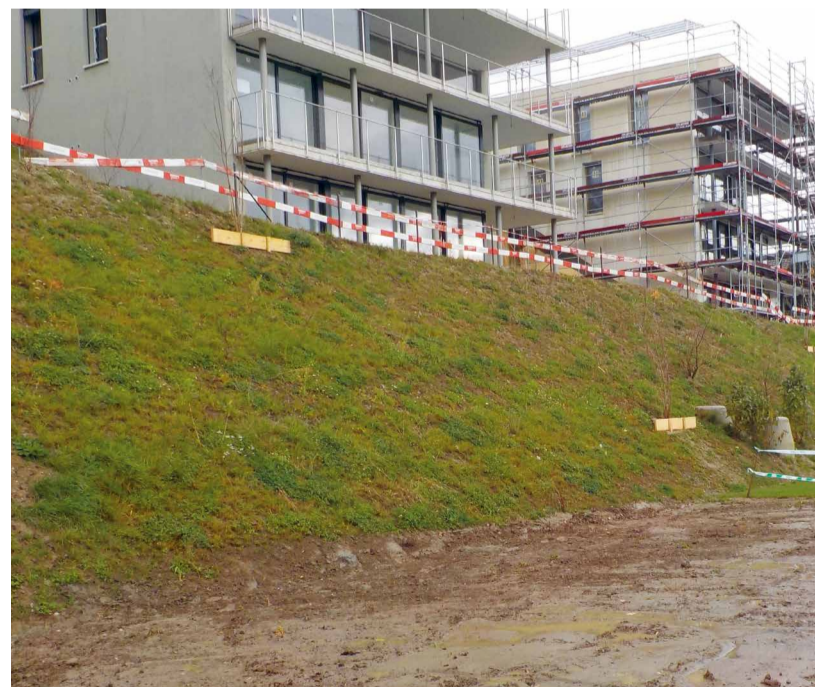
Der 100% biologisch abbaubare Erosionsschutz begünstigt die Keimung. Nach einigen Wochen sind die Gräser gut sichtbar.
