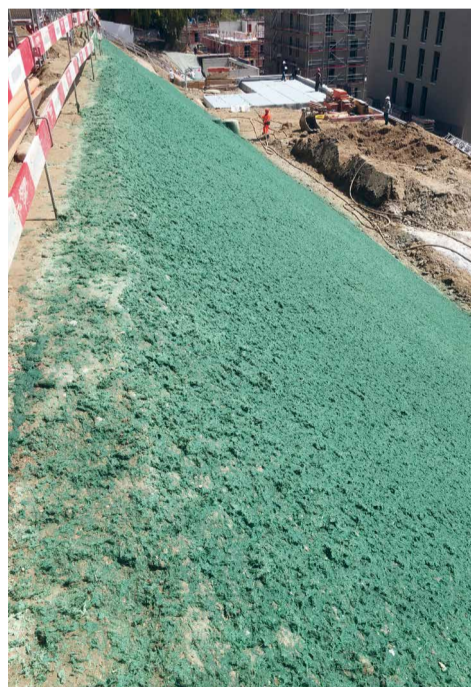
Die erosionsgefährdete Böschung wurde mit dem flüssigen Erosionsschutz Hydrosaat Protect abgedeckt.
