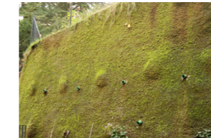
Moosbegrünung an Betonmauer
