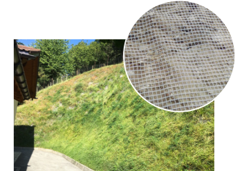
Begrünung nach Böschungssicherung mit Geogitter
