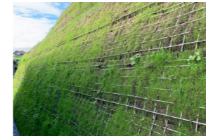
Aufspritzen von Substrat vor der Anspritzbegrünung
