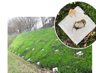
Begrünung nach Sicherung mit Ankern
