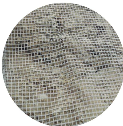
Le treillis antichute de pierres fixé sur la roche.
