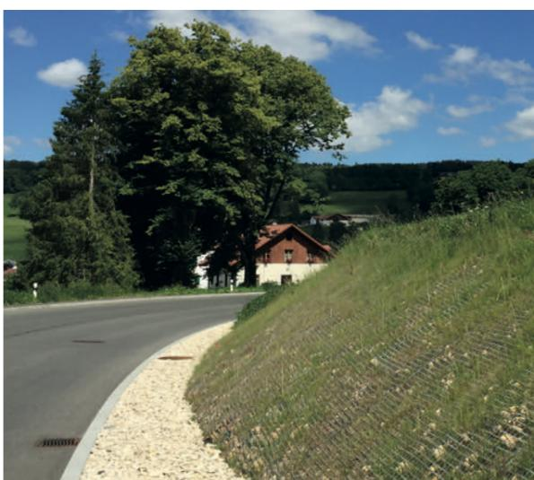
Un mélange de semence projeté directement sur le sol brut renforcé par un treillis.
