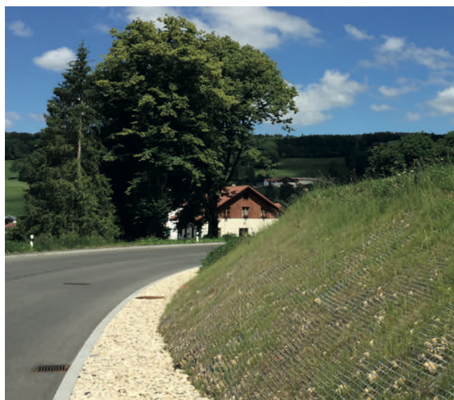
Die hydraulische Begrünung erfolgte durch das Geogitter auf den bestehenden Rohboden.
