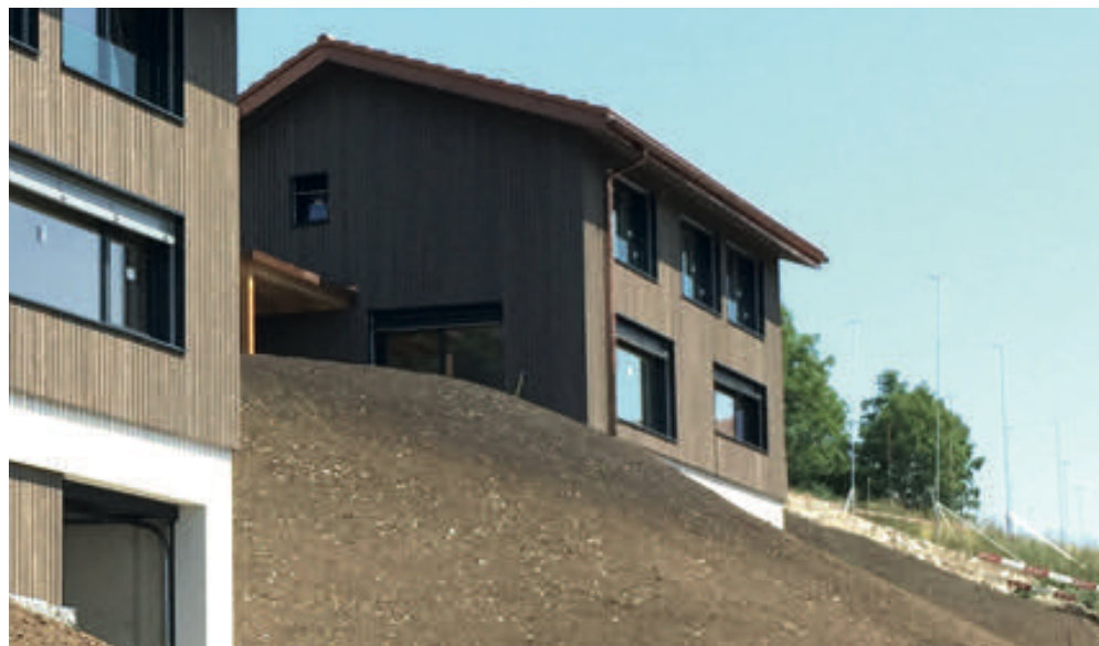
Die vorbereitete Böschung vor der Begrünung.
