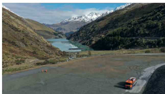
Die erste Equipe bei der Ansaat mit Schläuchen mit Blick auf den See.
