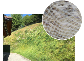
Begrünung nach Böschungssicherung mit Geogitter
