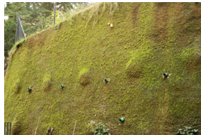
Moosbegrünung an Betonmauer
