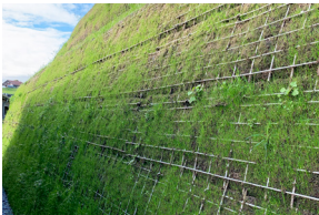
Aufspritzen von Substrat vor der Anspritzbegrünung
