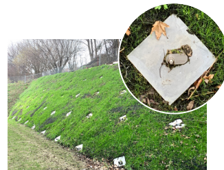
Begrünung nach Sicherung mit Ankern
